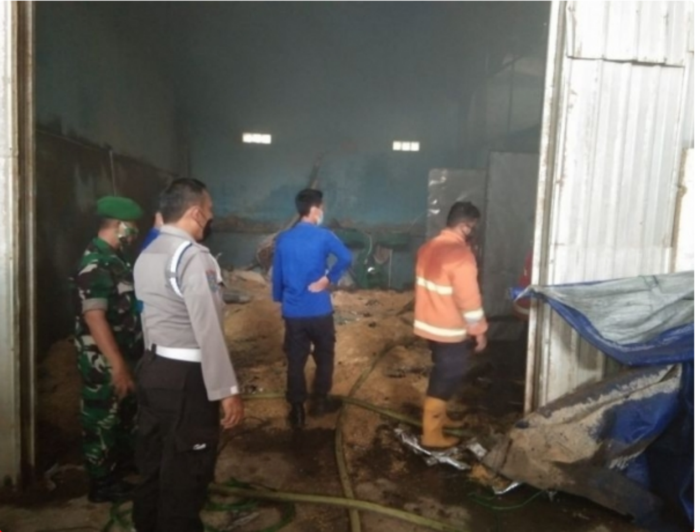
Pabrik Kayu di Kaligondang Terbakar
