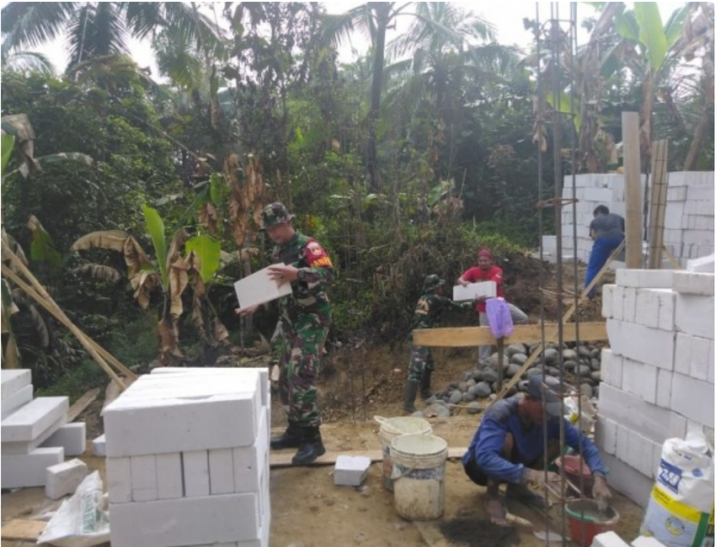
REHAB RUMAH: Danposramil Bojongsari bersama anggotanya dan masyarakat tengah membantu rehab rumah milik Tursini pasca kebakaran menghanguskan rumahnya. (Foto: Pendim 0702/Purnalingga)
